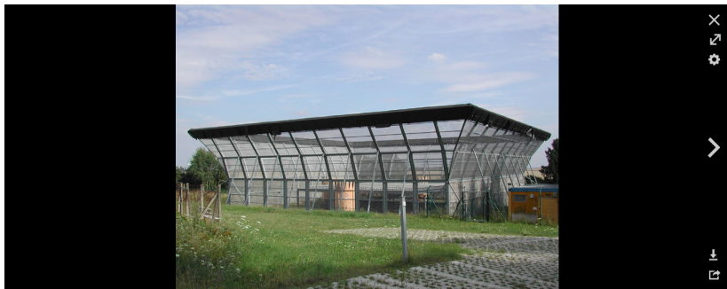
Ehemaliger Windprofiler am Meteorologischen Observatorium Lindenberg
